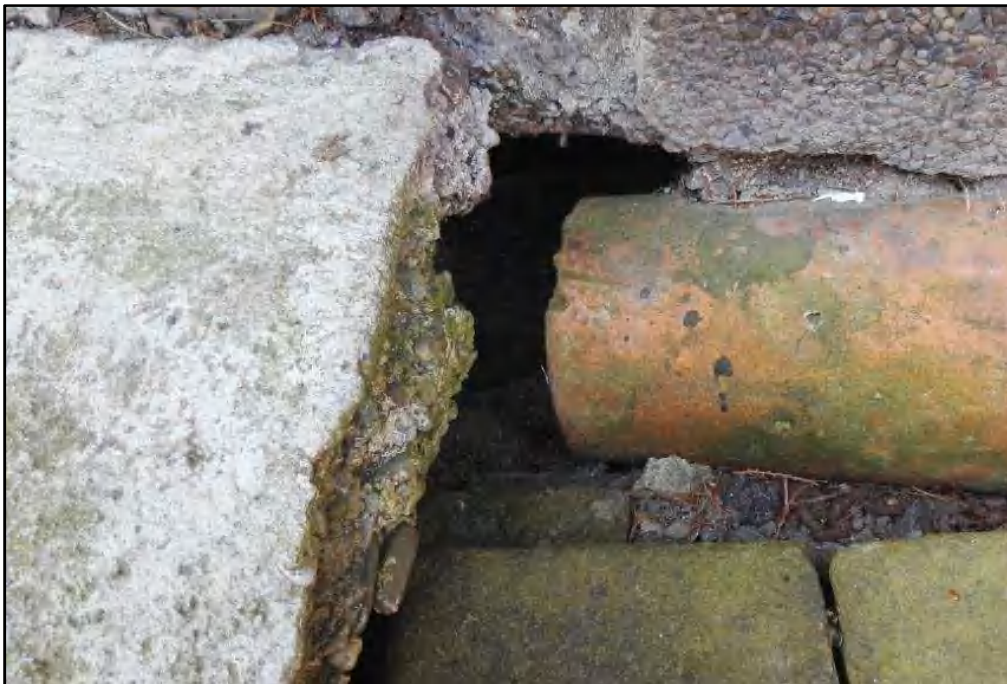
Abbildung 28: Lücken im Mauerwerk zum Kellerraum der Scheune.
