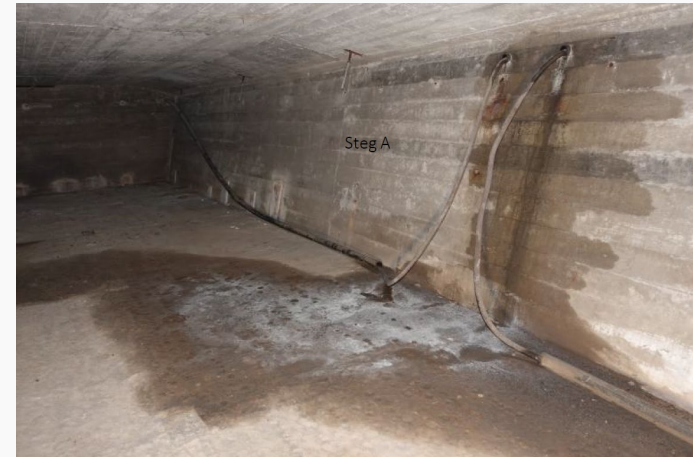
Chlorideintrag und Durchfeuchtung durch Kabeldurchführung und Einstiegsschächte
