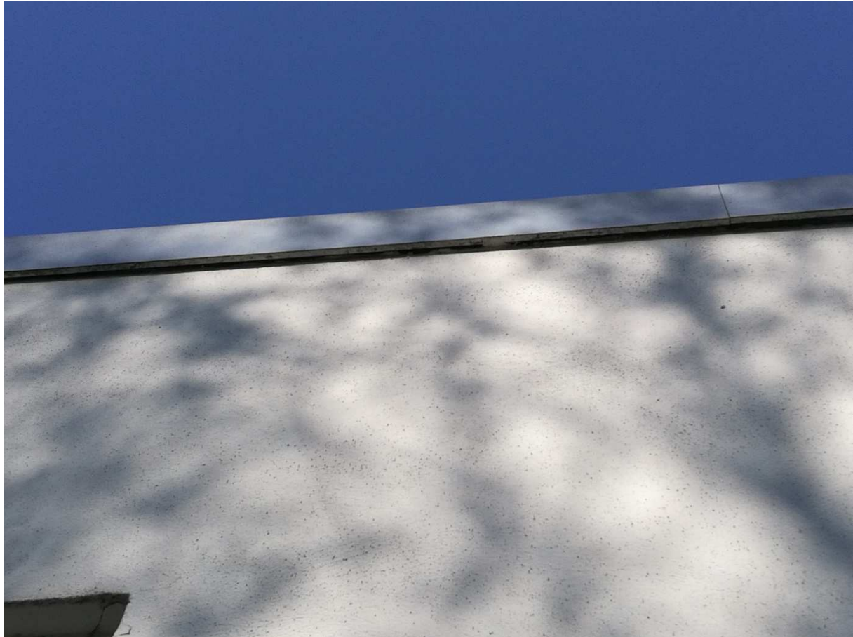
Abbildung 6: Spalte zwischen Dachaufkantung und Gebäudewand
