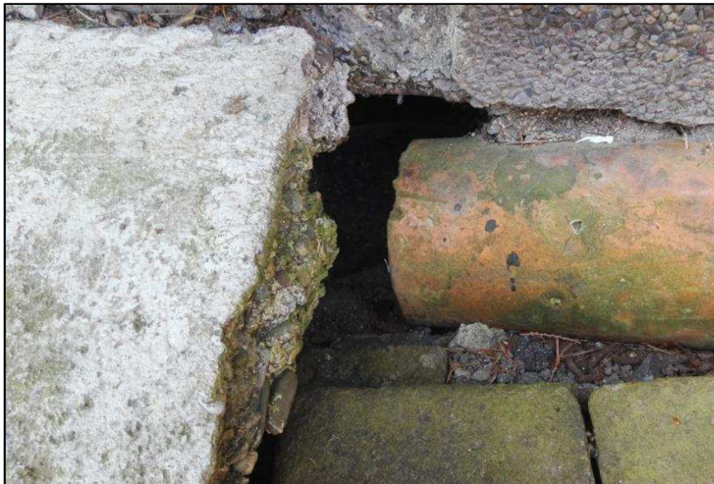
Abbildung 28: Lücken im Mauerwerk zum Kellerraum der Scheune.
