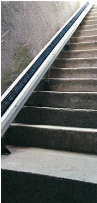
Abb. 4: Schieberille mit Bürsten (abwärts)
