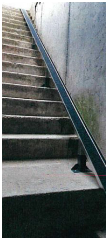
Abb. 5: Schieberille mit Anti-Rutsch-Aufkleber (aufwärts)
