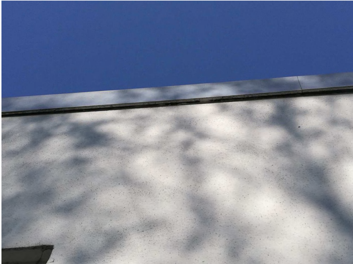
Abbildung 6: Spalte zwischen Dachaufkantung und Gebäudewand
