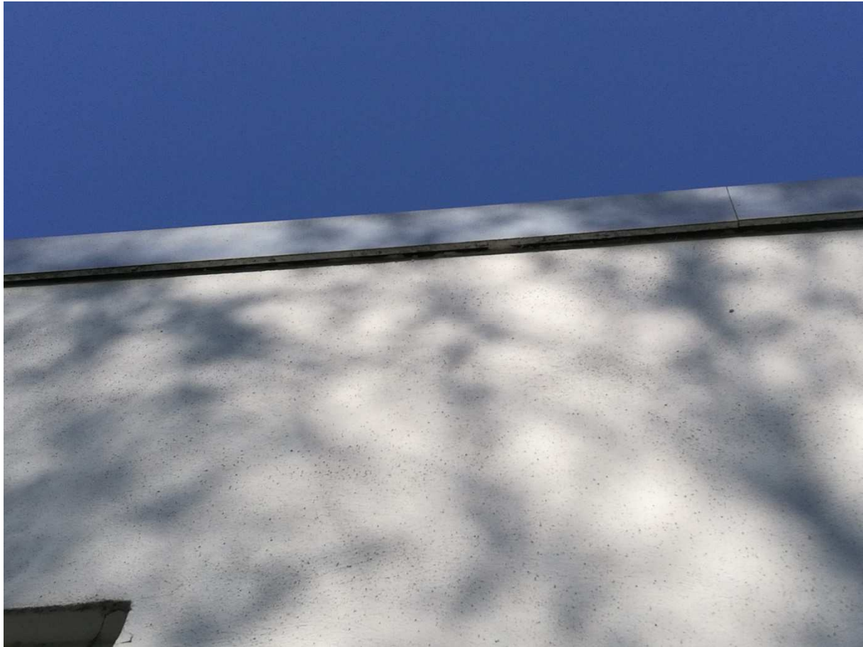
Abbildung 6: Spalte zwischen Dachaufkantung und Gebäudewand
