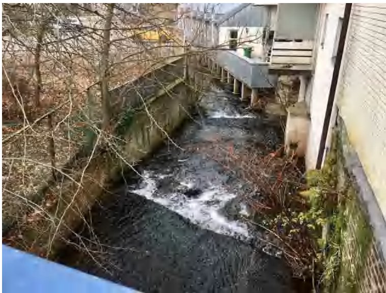
Blick über den offenen Abschnitt des Hasper Baches mit Gleite am Ende der Verrohrung Markanastraße
