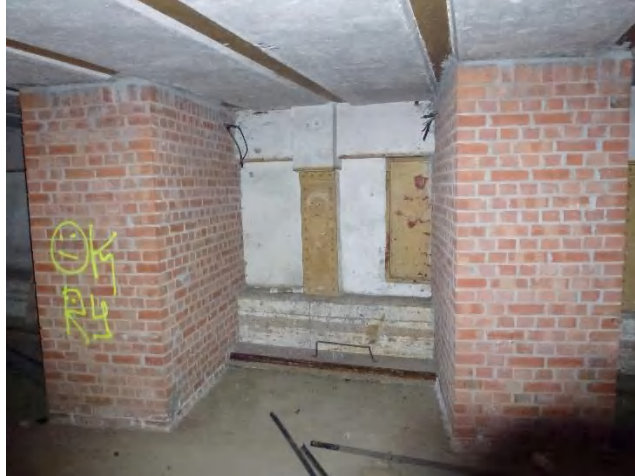
Abbildung 4: eingezogene Säulen im Posttunnel im Bereich Bahnsteig 2
