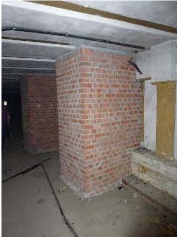
Abbildung 4: eingezogene Säulen im Posttunnel im Bereich Bahnsteig 2
