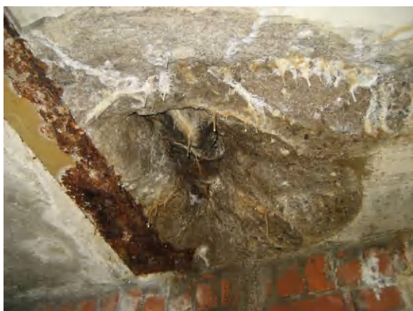
Abbildung 17: Detail durchfeuchteter Deckenbereich
