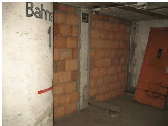
Abbildung 8: Abmauerung Bahnsteigzugang
