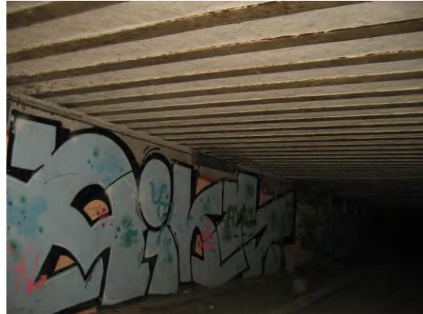
Abbildung 4: WIB-Decke am Tunnelanfang
