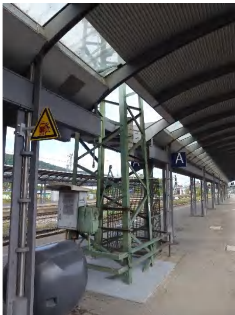
Abbildung 7: Sonderkonstruktion des Bahnsteigdaches im Bereich des bestehenden Oberleitungsmastes auf Bahnsteig 2
