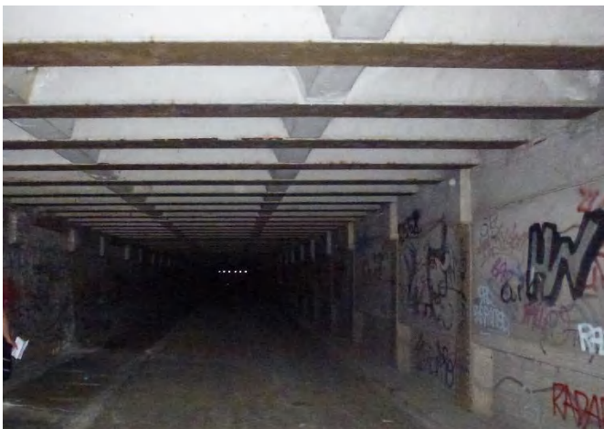
Abbildung 3: WIB-Überbau Haupttunnel
