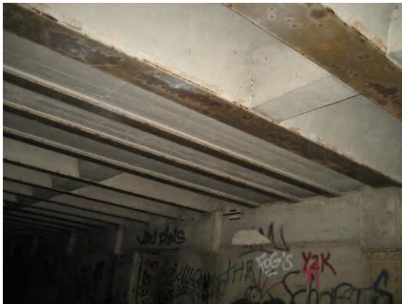
Abbildung 5: WIB-Decke in Tunnelmitte
