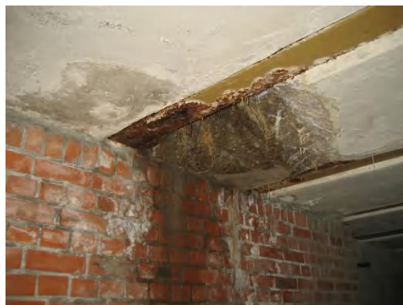
Abbildung 16: Undichte Decke unter Bahnsteig 3
