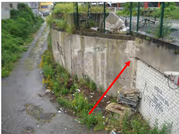
Abbildung 19: Südliche Stützwand Ausfahrtrampe Riss mit Versatz (roter Pfeil)
