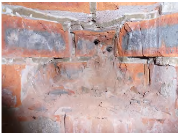
Abbildung 13: Öffnungsversuch Bahnsteig 3
