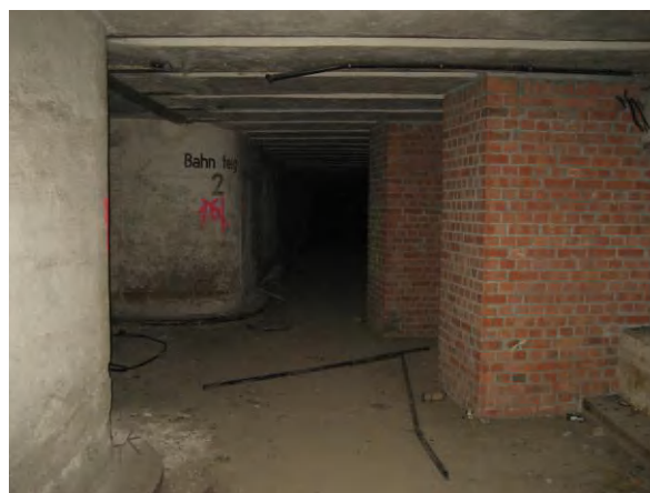
Abbildung 12: Abmauerungen unter Bahnsteig 2
