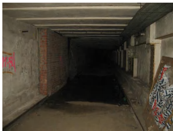
Abbildung 18: Wasseransammlung unter durchfeuchtetem Deckenbereich
