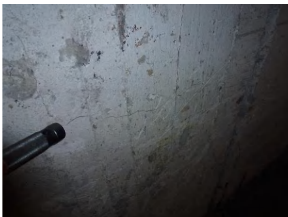
Abbildung 15: Risse in Wand zu Bahnsteig 2
