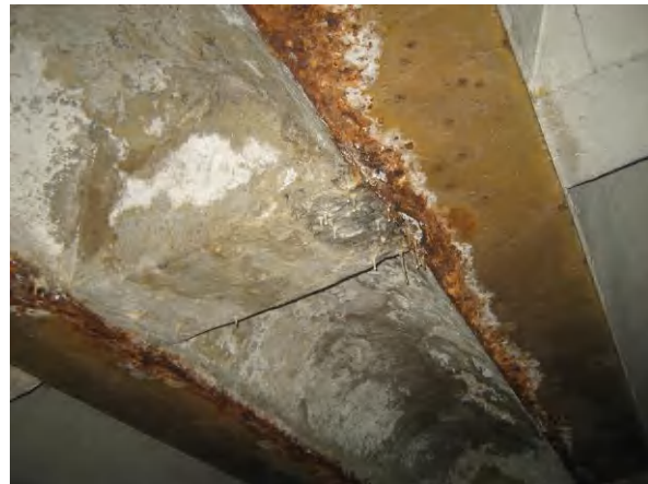
Abbildung 6: Einzelne Feuchtstelle im Deckenbereich
