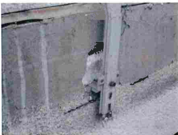
Abb. 1-3: Südseite des Wohngebäudes Trappenweg 10 mit in Gänze aufgenommener Attika und gut erkennbaren Hohlräumen
