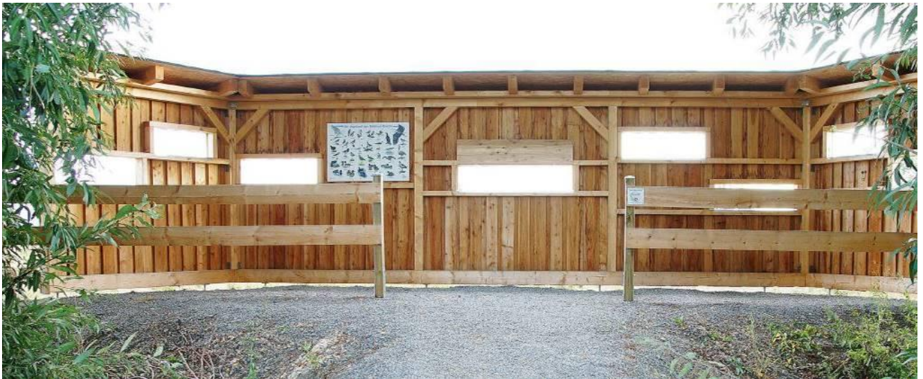
Beispiel 2: Aussichtsplattform mit geschlossener Vorderseite und Sichtscharten zur geschützten Beobachtung störungsempfindlicher Vogelarten
