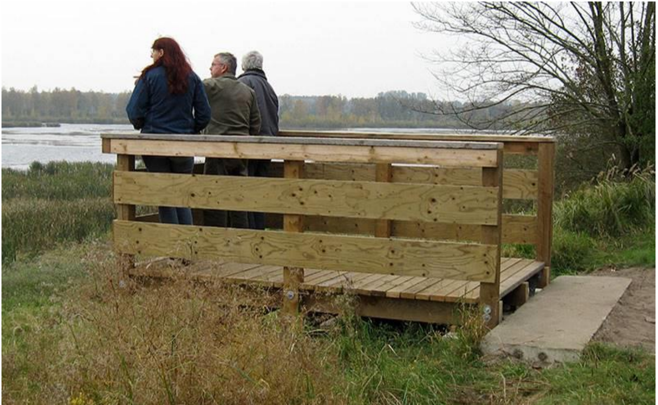
Beispiel 1: Einfache Aussichtsplattform am Flussufer mit Bodenplatte und Geländer
