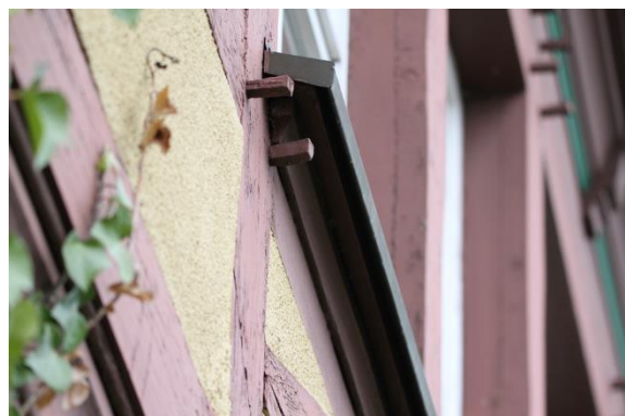
Abb. 11 Spalt unter der Fensterbank
