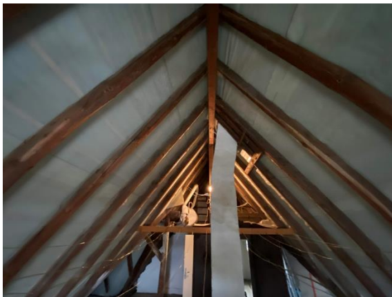
Abb. 14 Durch Folie abgedichteter Dachstuhl
