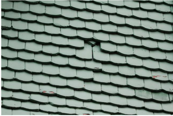
Abb. 12 Spaltbildung durch beschädigte Schindel
