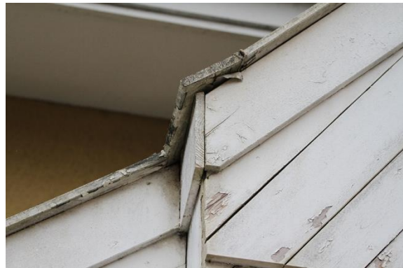
Abb. 7 Spalten an Außenholzverkleidung 2
