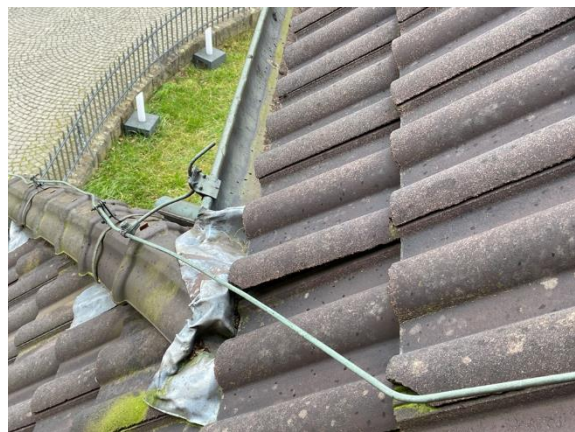
Abb. 9 Beschädigte Dachpfanne
