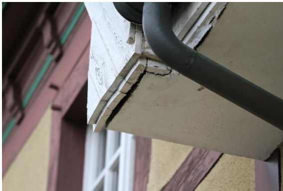
Abb. 6 Spalten an Außenholzverkleidung 1
