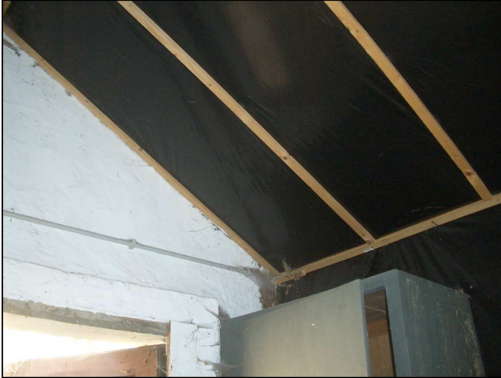
Abbildung 8: Dach mit Folie
