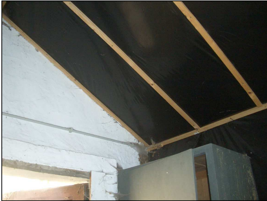
Abbildung 8: Dach mit Folie
