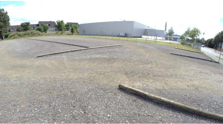
Beispiel Schotterparkplatz mit Rundholzeinfassung
