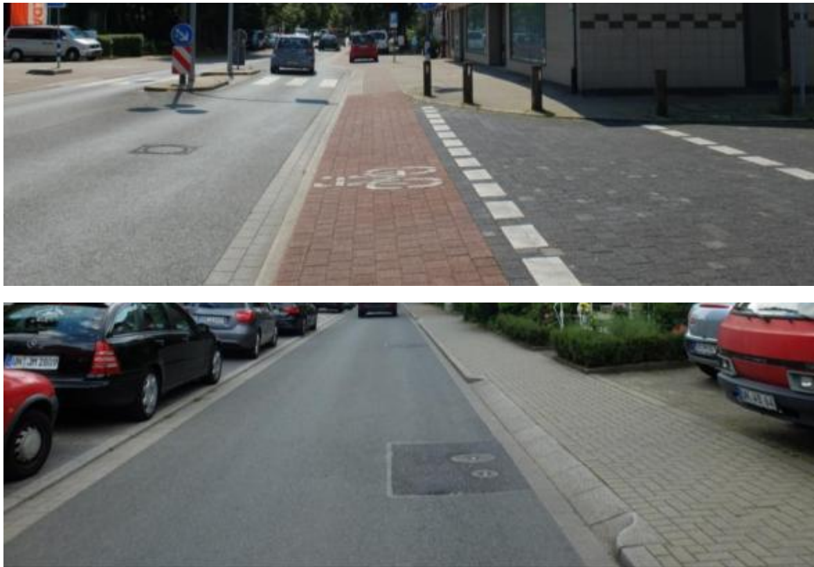
Abbildung 19: oben: Beispiel für eine weiterlaufende Pflasterung des Radwegs gegenüber untergeordneten Straßen; unten: Beispiel für einen Rampenstein an Grundstückszufahrten
