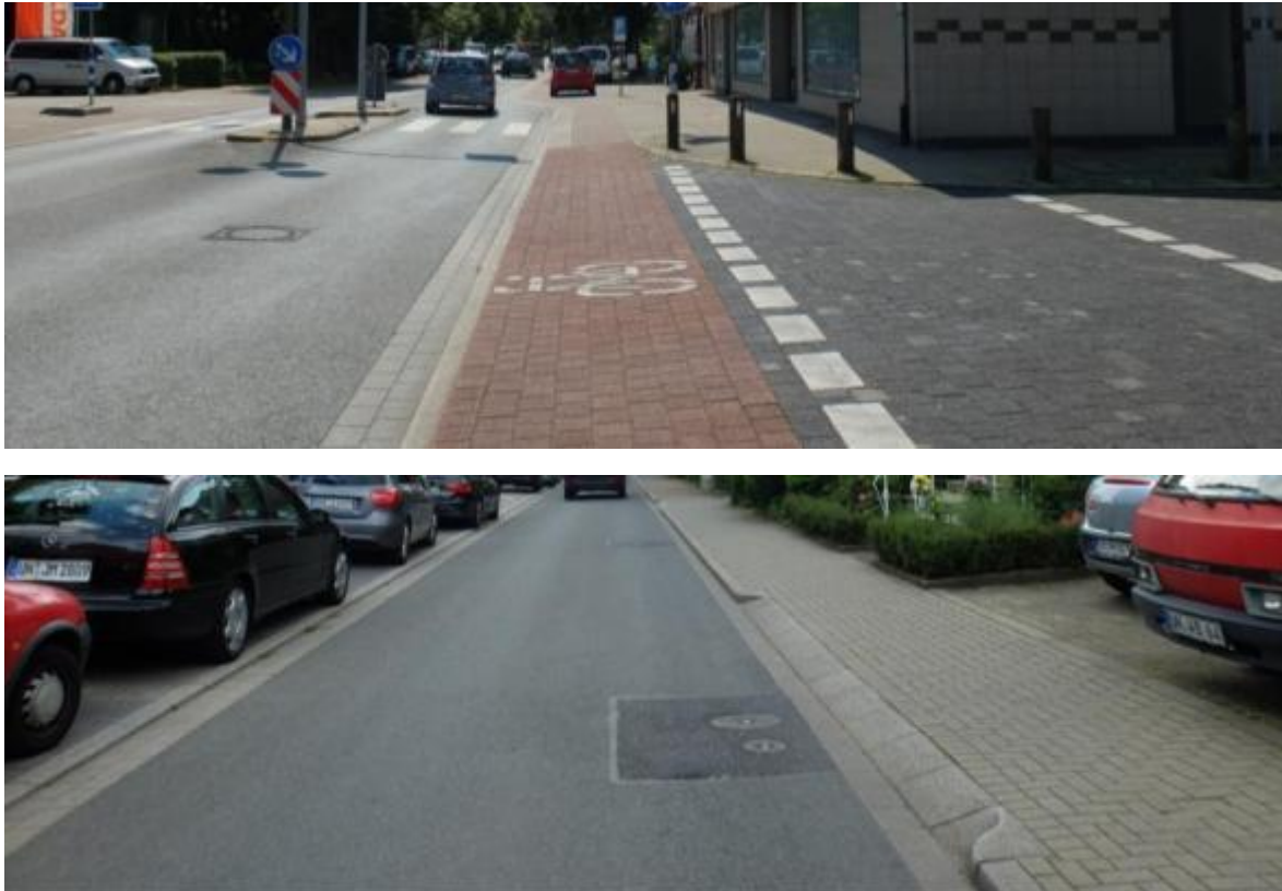
Abbildung 17: oben: Beispiel für eine weiterlaufende Pflasterung des Radwegs gegenüber untergeordneten Straßen; unten: Beispiel für einen Rampenstein an Grundstückszufahrten
