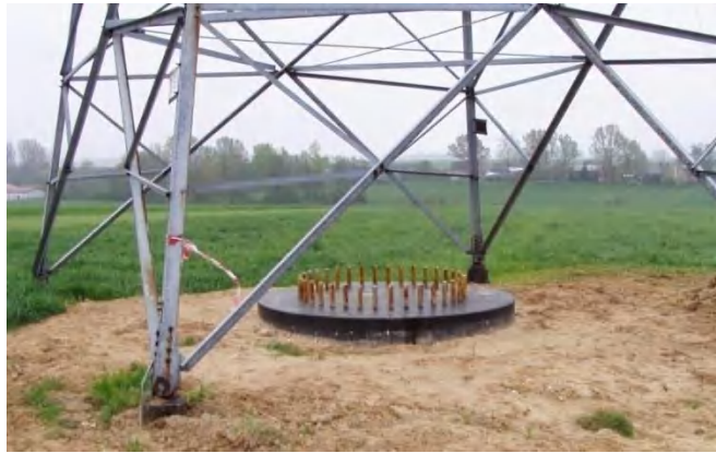
Plattenfundament mit Ankerkorb mit Einbindung der Altfundamente
