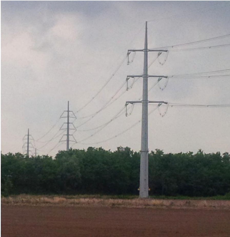
2x 380kV Leitung Italien, Abspann- und Tragmaste
