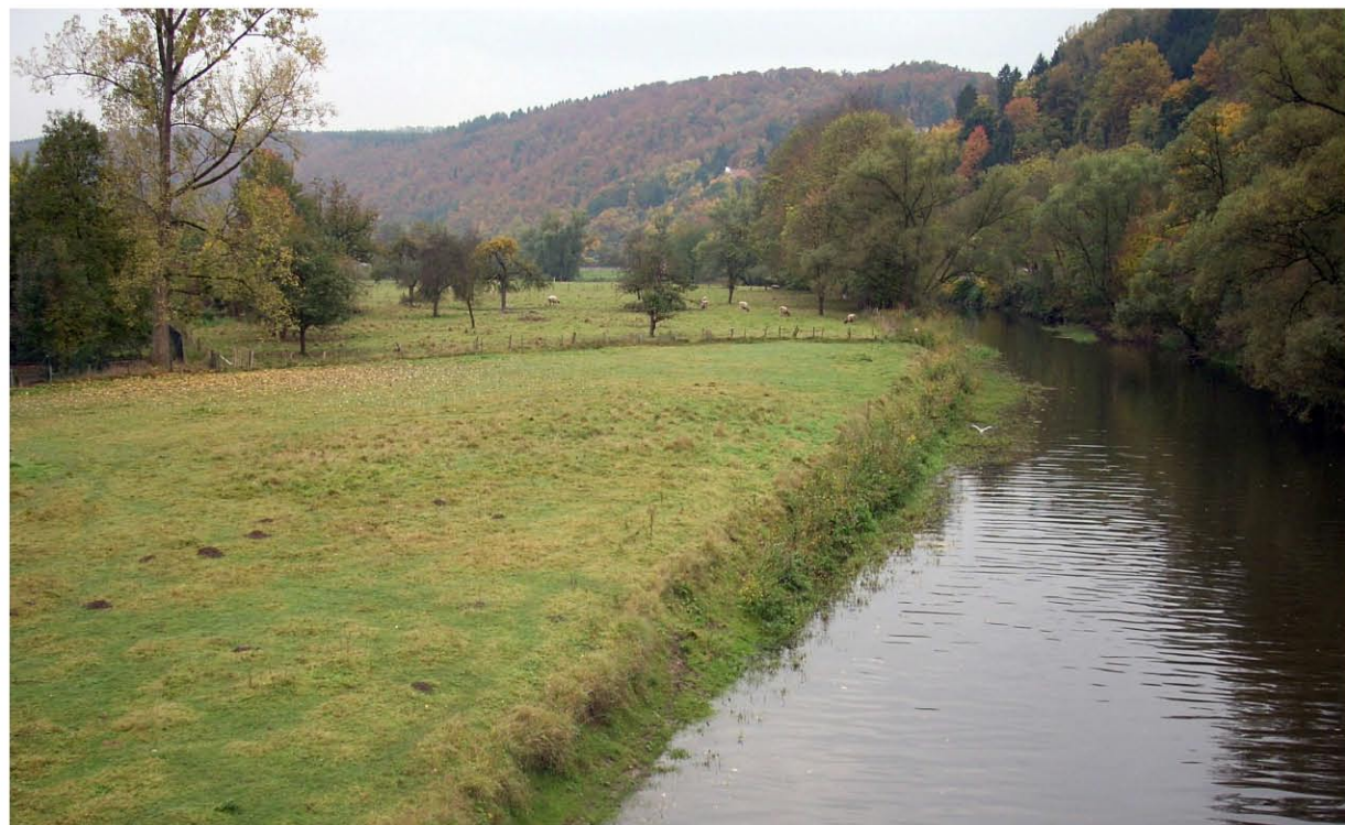
Dokumentation einer Renaturierungsmaßnahme an der Ruhr bei Arnsberg, die in Art und Umfang mit der dargestellten Planung vergleichbar ist. Auf der linken Abbildung aus dem Oktober des Jahres 2010 ist das Gelände vor Beginn der Erdarbeiten dargestellt. Der Ruhrlauf beschränkt sich auf ein strukturarmes, gleichförmiges Gewässerbett mit befestigten Ufern.
