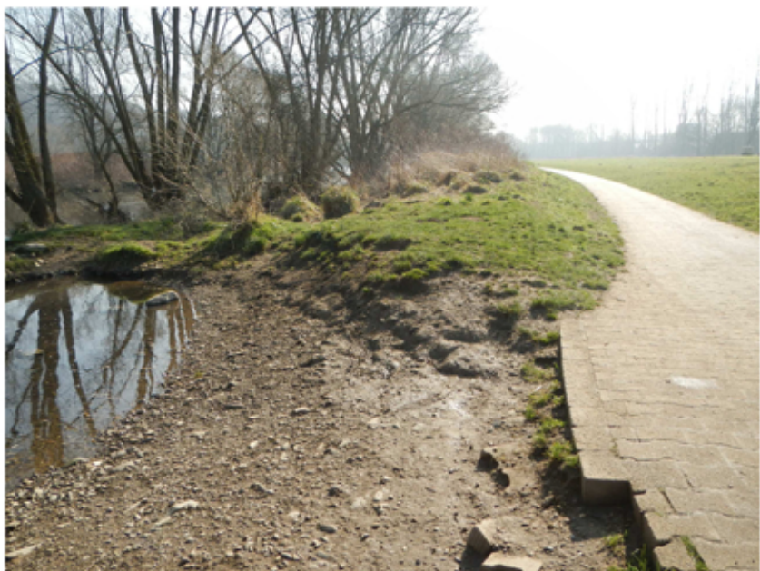
Bild 4: Der Fuß- und Radweg aus Verbundpflaster ist im Bereich der Auskolkung bei Station 2+755 abgängig
