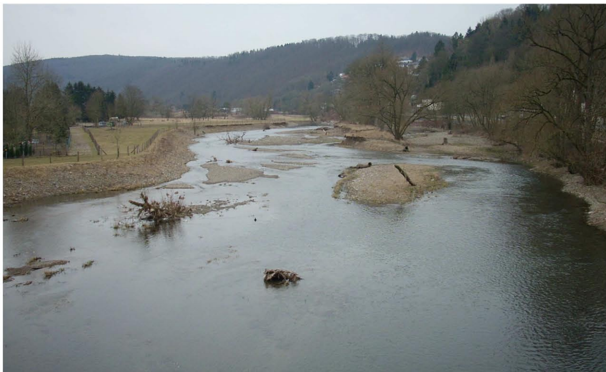
Die Aufnahme aus dem März 2012 zeigt, wie der Ruhrlauf auf das 3 - 4 fache der ursprünglichen Breite aufgeweitet wurde. Ehemalige Uferfragmente mit Altgehölzen strukturieren das breite und flache Gewässerbett, das bei normalen Abflussverhältnissen von weiten, umlagerungsfähigen Kiesflächen geprägt wird.
