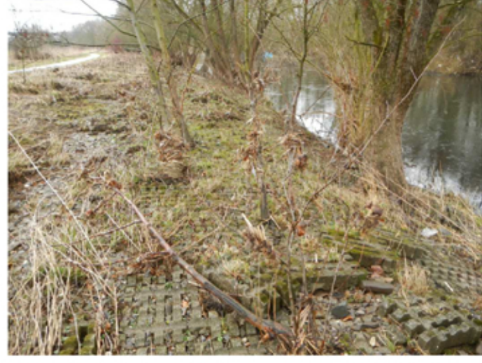
Bild 2: Die technische Sicherung mit Rasengittersteinen des linksseitigen Lenneufers ist teilweise bereits verfallen
