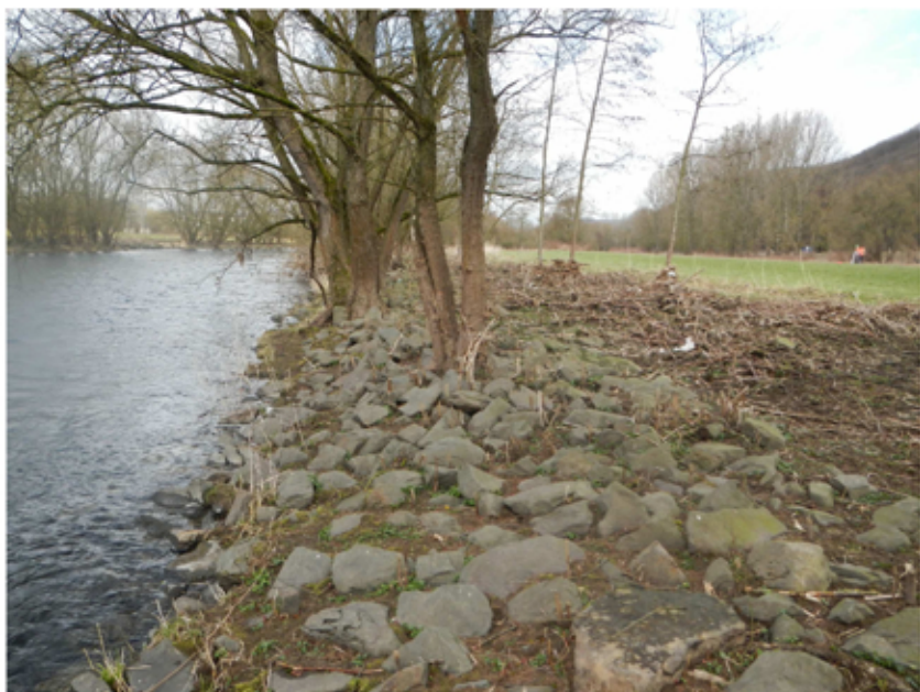
Bild 3: Abschnittsweise ist die im Trapezprofil gefasste Lenne auch mit Steinsatz befestigt, wie hier bei Station 2+930 in Fließrichtung gesehen
