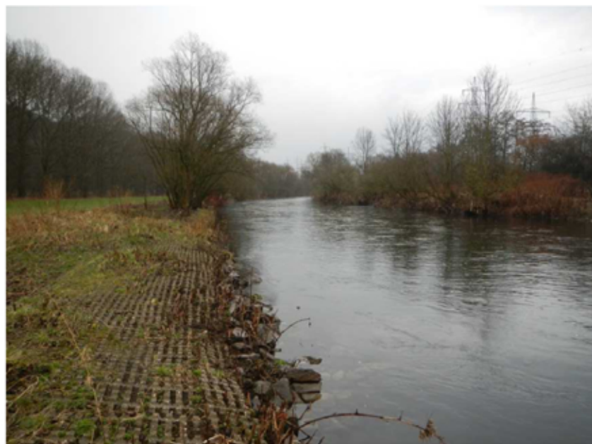
Bild 1: Blick gegen die Fließrichtung der Lenne auf den massiven Uferversbau aus Rasengittersteinen bei Station km 3+170
