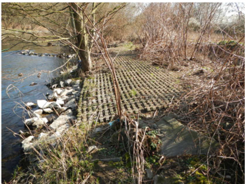
Bild 6: Blick gegen die Fließrichtung der Lenne auf den massiven Uferversbau aus Rasengittersteinen bei Station km 3+150
