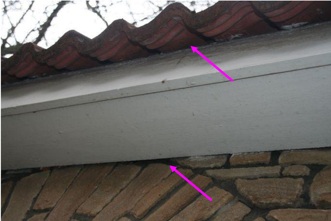
Abb. 10: Dach des Torbogens mit potenziellen Spaltenquartieren
