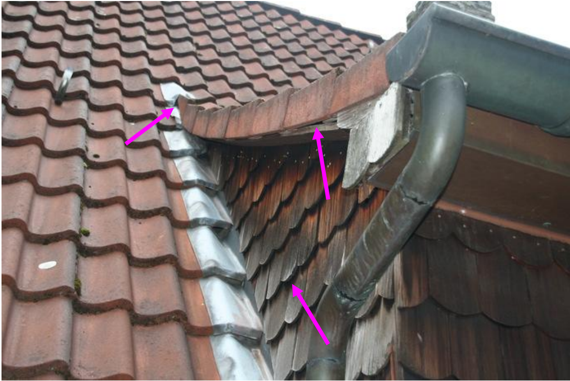
Abb. 6: Detail der Schleppgaube mit potenziellen Spaltenquartieren
