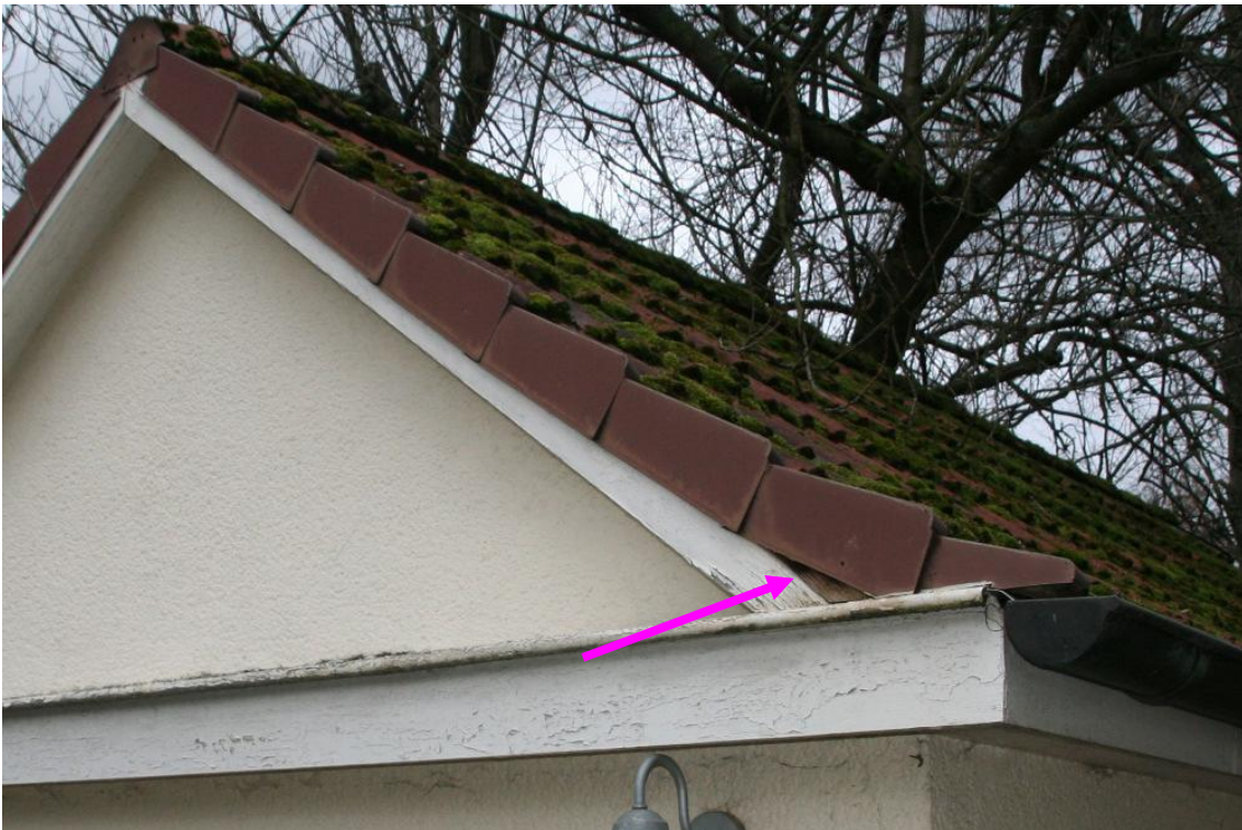
Abb. 9: Dachbereich der Garage mit potenziellen Spaltenquartieren
