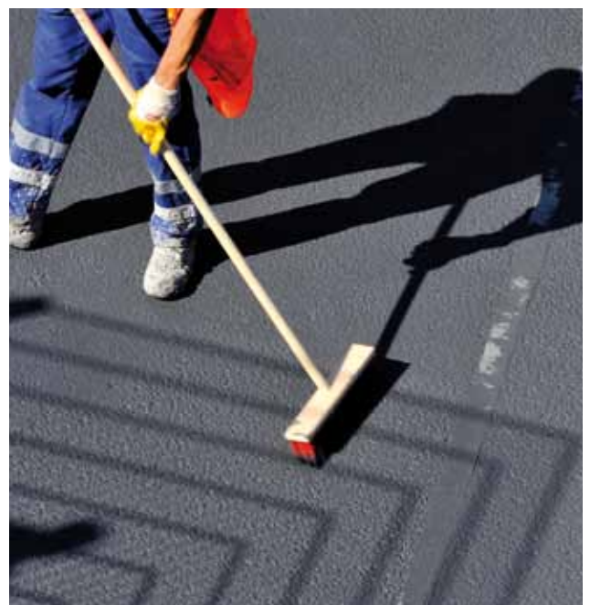
Aufbringen der NOxer®-Zementsuspension
