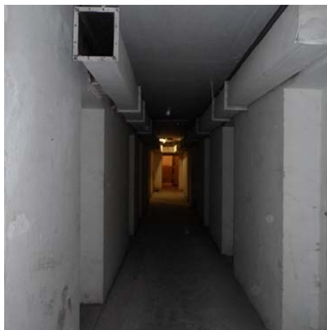
Bauzeitliche Lüftungskanäle und Zellentüren
