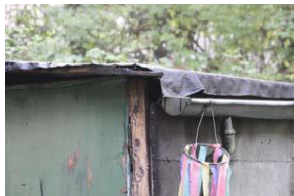
Abb. 23: Spalten zwischen der Dachpappe einer Gartenlaube auf der Fläche A
