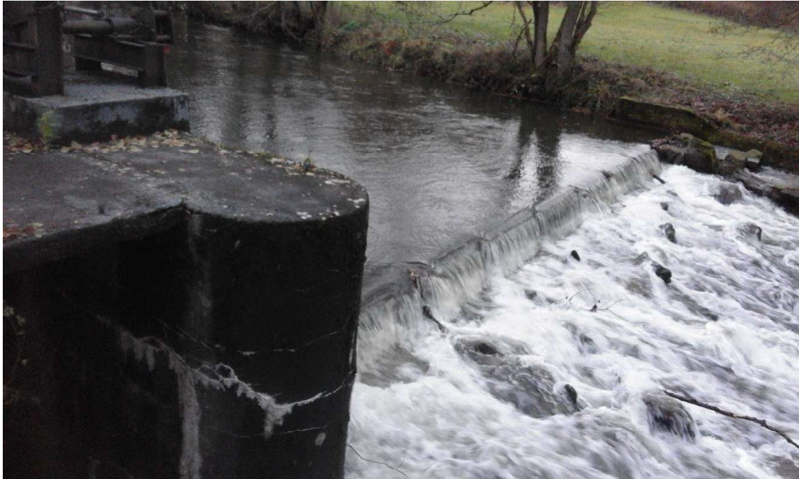
Bild 01 Seitenansicht der Stauanlage, Fischaufstieg rechts oben (2017)
