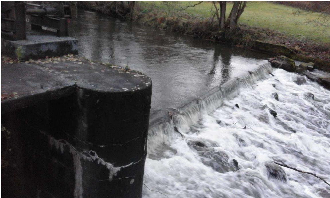
Bild 01 Seitenansicht der Stauanlage, Fischaufstieg rechts oben (2017)
