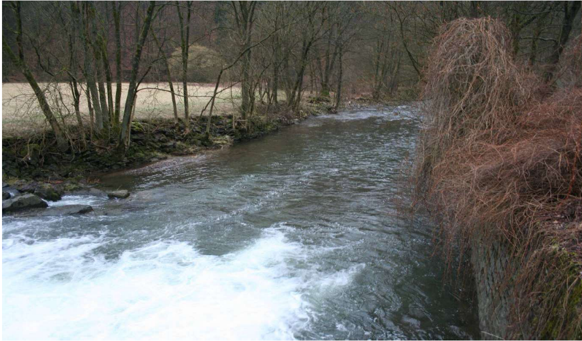
Bild 03 unterwasserseitiger Einstieg in die FAA (Endriegel noch sichtbar) (2015)
