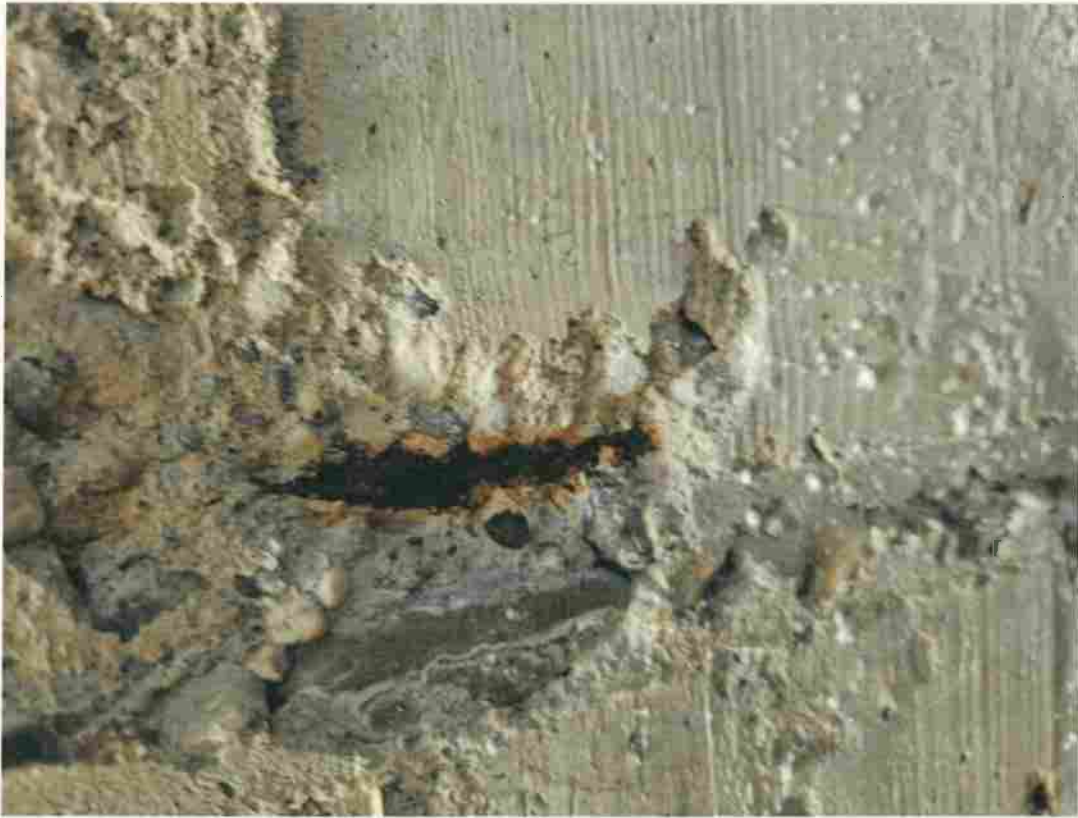
Bild K5: Detaildarstellung der verrosteten Konstruktion
