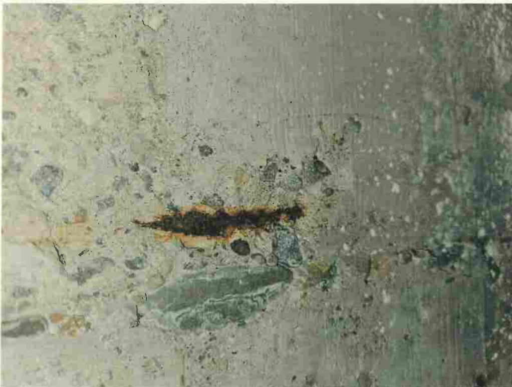
Bild K6: Detaildarstellung der verrosteten Konstruktion
