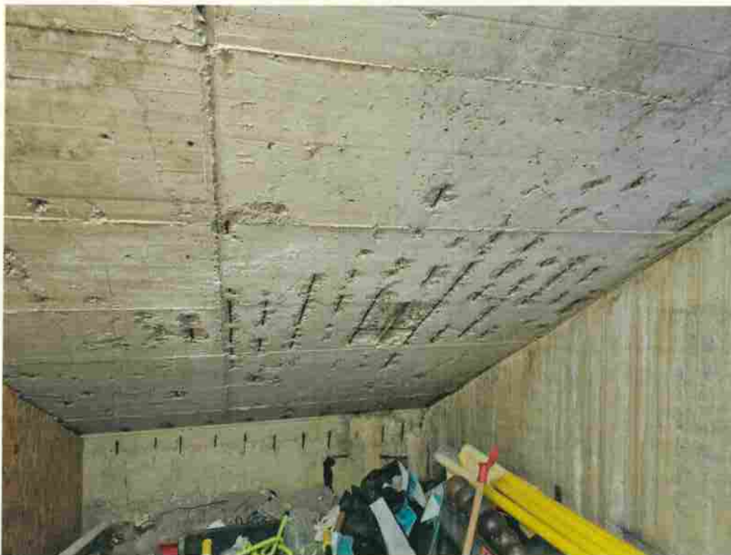
Bild K4: Unterkonstruktion (Biegebereich), freiliegende Bewehrung
