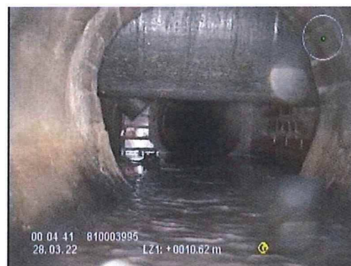
Abbildung 3: Auszüge aus der Fotodokumentation und der Kamerabefahrung vom 28.03.2022 – Querschnitteinengungen
