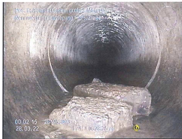
Abbildung 2: Auszüge aus der Fotodokumentation und der Kamerabefahrung vom 28.03.2022 – Eintrag von großem
