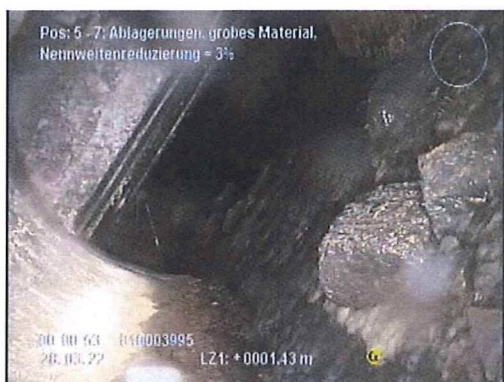
Abbildung 3: Auszüge aus der Fotodokumentation und der Kamerabefahrung vom 28.03.2022 – Querschnitteinengungen
