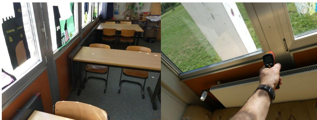
Heizflächen im Klassentrakt (bauzeitlich) und teilerneuert in der Verwaltung
