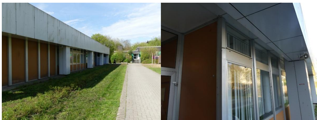
Teilsanierung der Fassade am Alulatrakt Verwaltungsbereich Inkonsequente und teilweise improvisierte Detaillösungen
