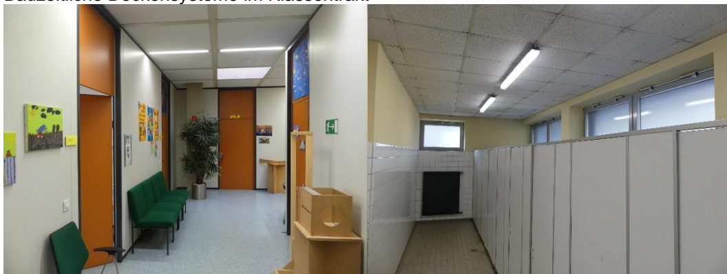
Bauzeitliche Deckensysteme im Verwaltungstrakt, neuzeitliches System im Pausen-WC
