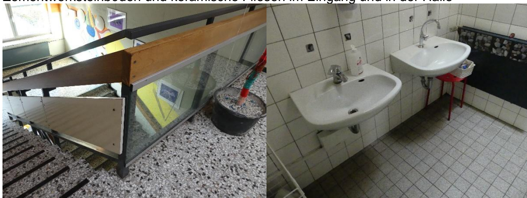
Zementwerksteinböden im Treppenhaus und sehr einfache Fliesen in den WC-Anlagen
