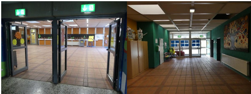
Zementwerksteinböden und keramische Fliesen im Eingang und in der Halle
