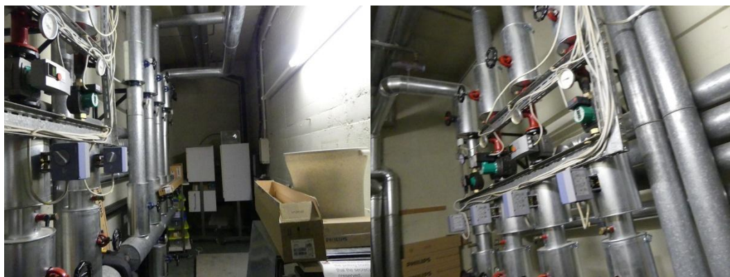
Heizungsraum mit zentraler Verteilung
