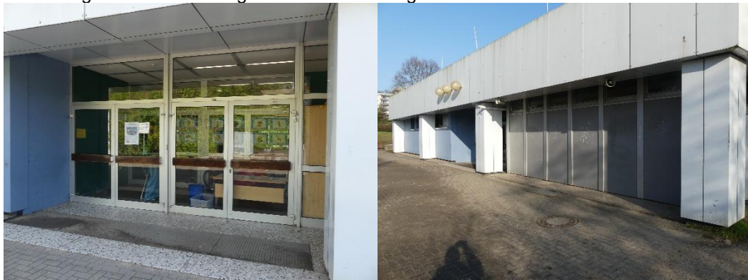
Neue Fassadenverkleidung aber alte Türen im Aulatrakt
