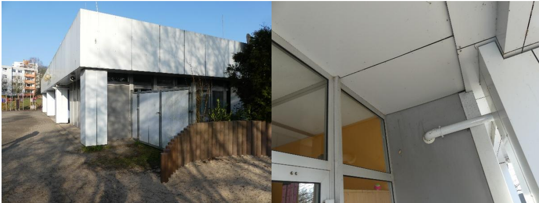
Fassade Aula/Verwaltung HM mit Verkleidung ohne Wärmeschutz
