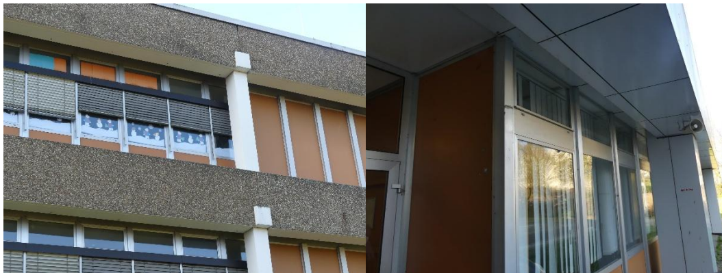
Fensterkonstruktionen mit unzureichendem Sonnenschutz am Klassentrakt, Alulatrakt
