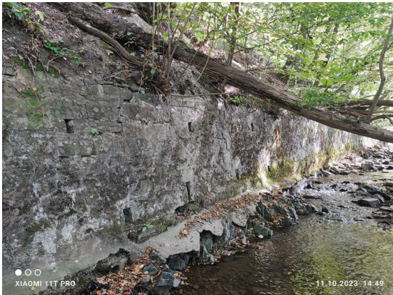
Foto: Böschungsabbrüche durch die Hochwasserereignisse
