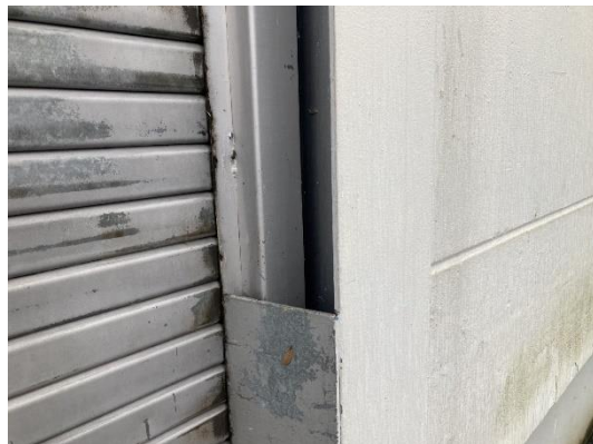
Abb. 8 Spalte an einem Tor.
