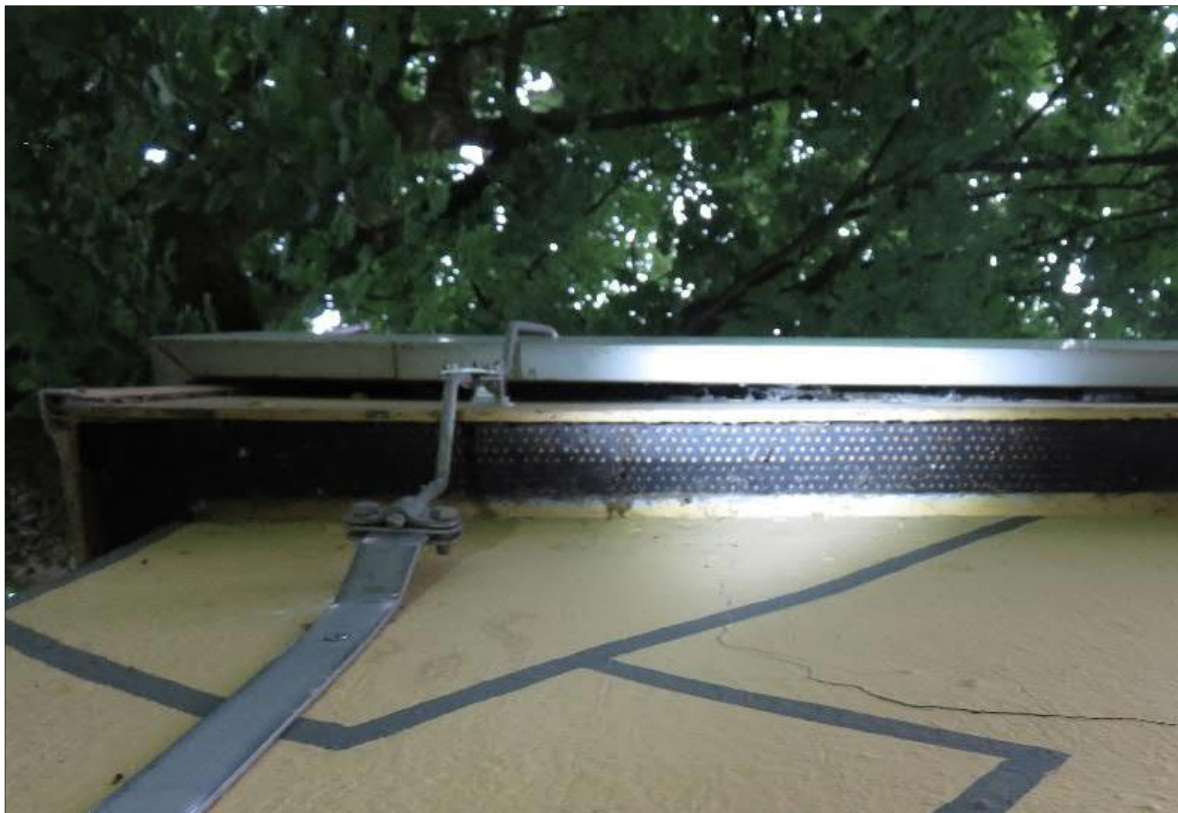
Abbildung 5: Spaltenräume zwischen Metallverkleidung und Fassade
